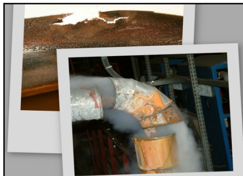
Korrosionserosion kann undichte Stelle an Rohrbögen verursachen
